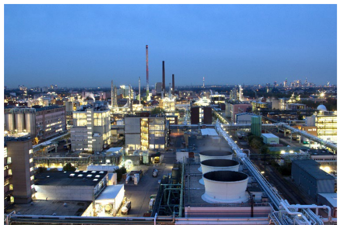
Der Industriepark Höchst (Foto: Infracorv)
