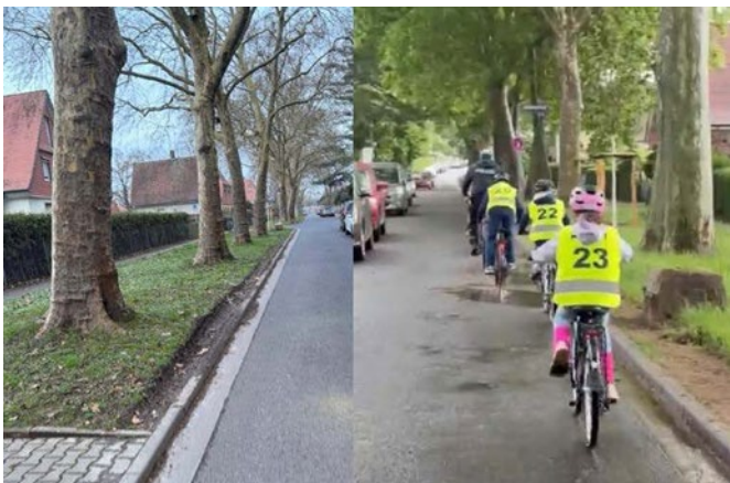
Links im Bild der durch Befahren zerstörte Randstreifen. Im rechten Bild, aus der anderen Richtung aufgenommen, radeln die Kinder am wiederhergestellten und durch Steine gesicherten Fahrbahnrand vorbei.
